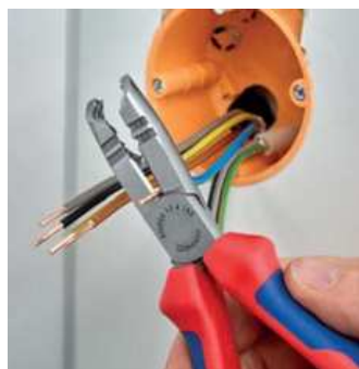
Řezání při zkracování jednotlivých vodičů
